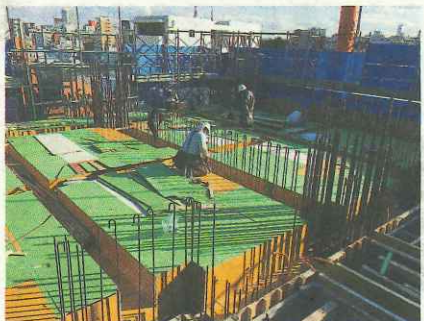
ドルフィンコートの緑色が映える（日暮里のRC造マンション施工現場）
