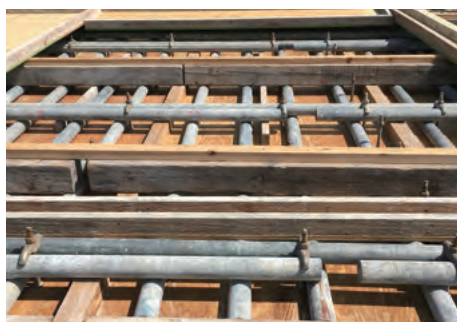
宮城県クリーンセンター建設工事⑥
