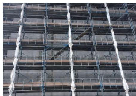
広島県橋梁工事①
