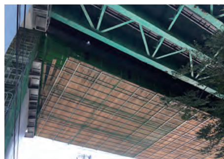
東北自動車道塗替工事④
