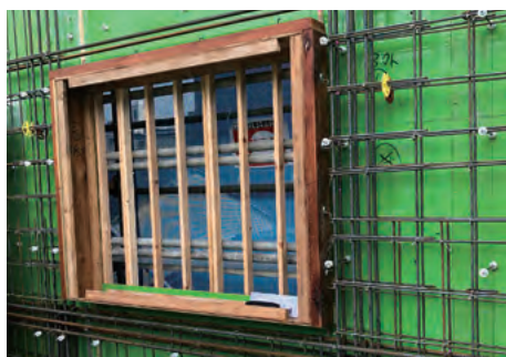
都内マンション建設現場③
