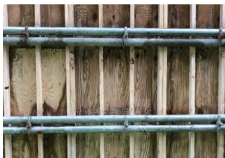
都内マンション建設現場④
