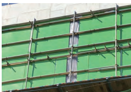
東北自動車道塗替工事①
