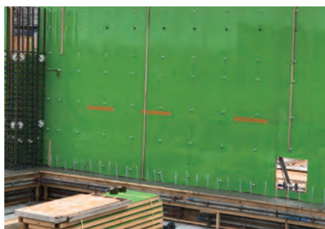
都内学校建設現場①
