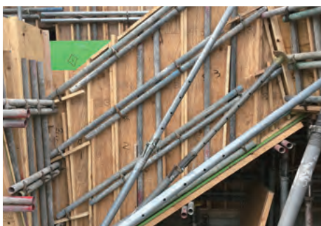
動物園畜舎建設工事③
