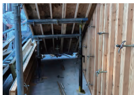
都内マンション建設現場⑩
