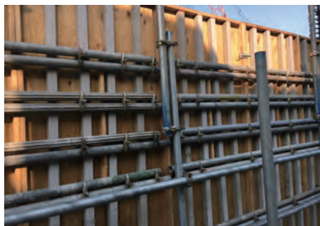
都内マンション建設現場③
