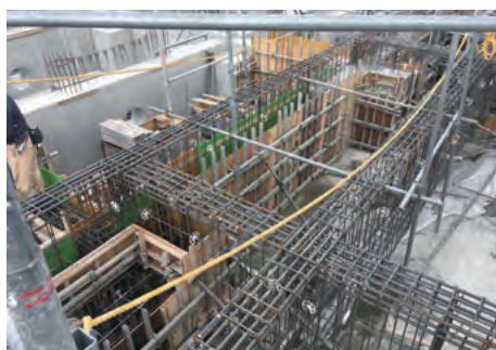
徳島県公共施設建設工事①
