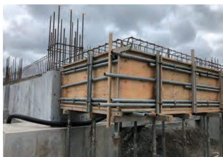
山田町水道ポンプ施設工事①
