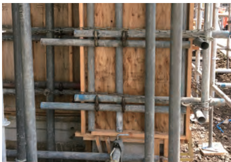
動物園畜舎建設工事①
