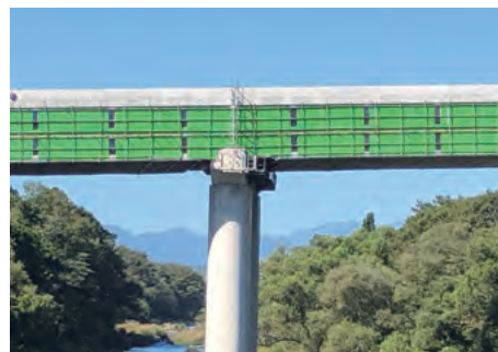
東北自動車道塗替工事③
