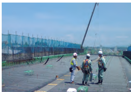
北陸新幹線床板工事①
