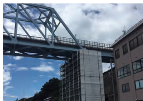
広島県橋梁工事②
