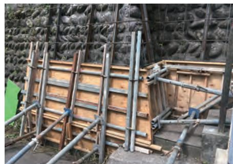
個人邸宅擁壁補強工事①
