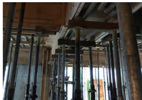
都内マンション建設現場⑨
