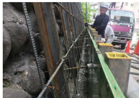
個人邸宅擁壁補強工事③
