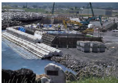
気仙沼市防潮堤工事①
