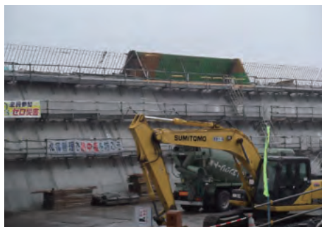
気仙沼市防潮堤工事④
