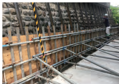
個人邸宅擁壁補強工事②
