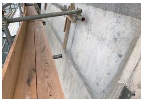
山口県防潮堤工事④
