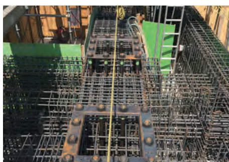
宮城県クリーンセンター建設工事②
