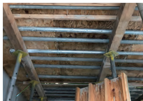
都内マンション建設現場⑧
