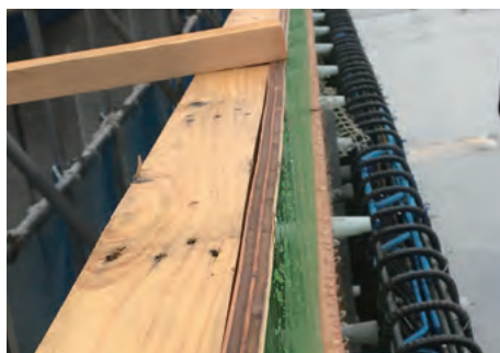
新東名相模原JCT高欄工事②
