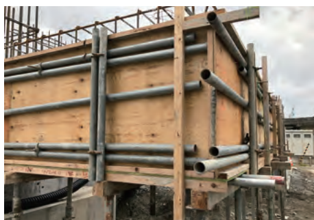
山田町水道ポンプ施設工事②
