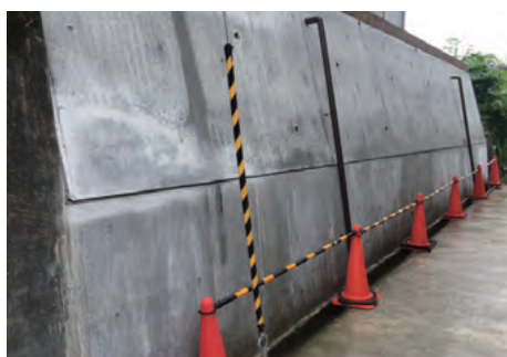
個人邸宅擁壁補強工事⑥
