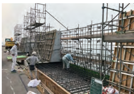
山口県防潮堤工事①
