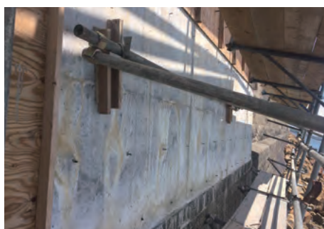
山口県防潮堤工事③
