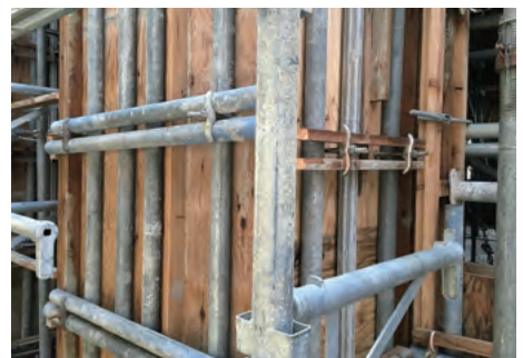
長野県学校建設工事③
