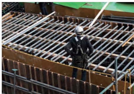
神奈川県商業施設建設現場③
