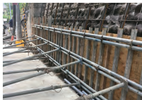
個人邸宅擁壁補強工事④
