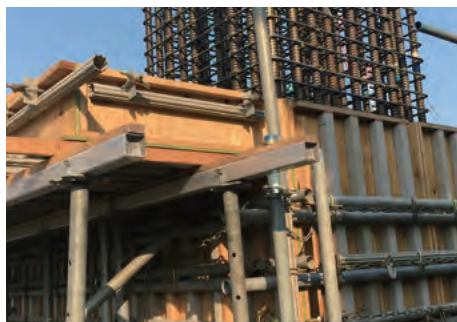
都内マンション建設現場④
