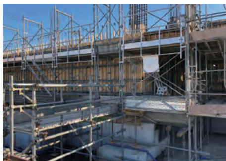
都内集合住宅建設現場②
