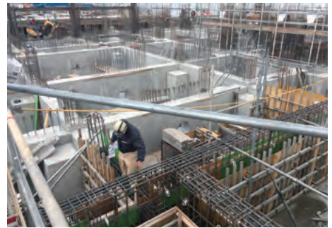
徳島県公共施設建設工事②
