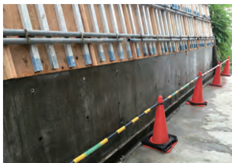
個人邸宅擁壁補強工事⑤
