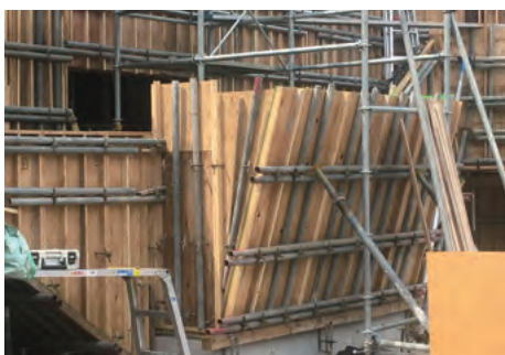
動物園畜舎建設工事④
