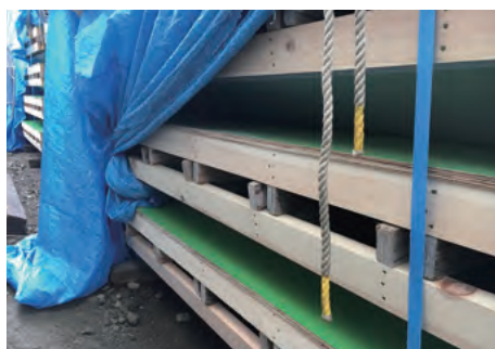
新東名相模原JCT高欄工事④
