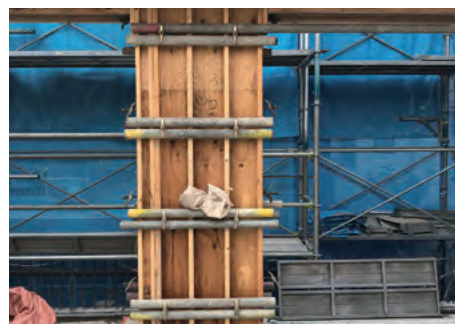
都内マンション建設現場⑥
