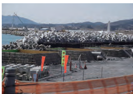
気仙沼市防潮堤工事②
