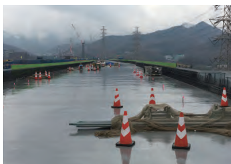
新東名相模原JCT高欄工事③
