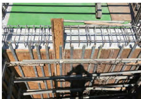
宮城県クリーンセンター建設工事⑤
