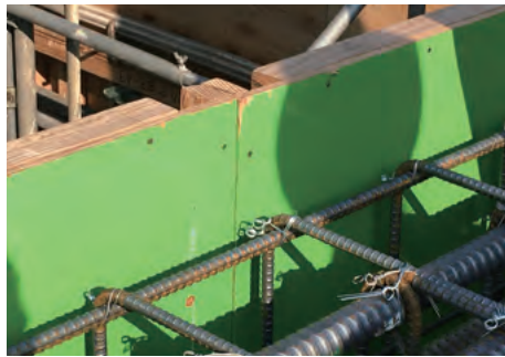
都内マンション建設現場①
