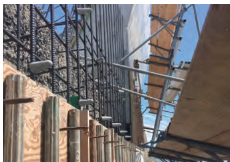
山口県防潮堤工事②
