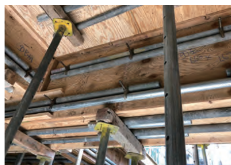
都内マンション建設現場⑦
