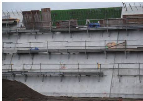
気仙沼市防潮堤工事③
