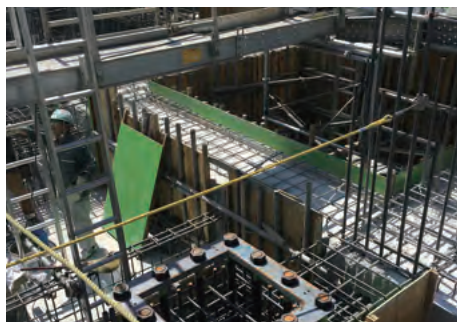
宮城県クリーンセンター建設工事④
