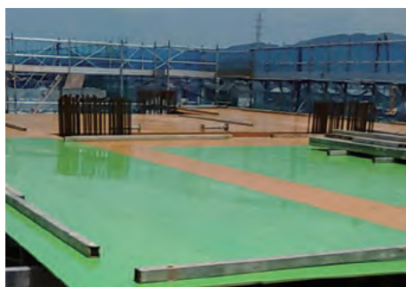
北陸新幹線床板工事③
