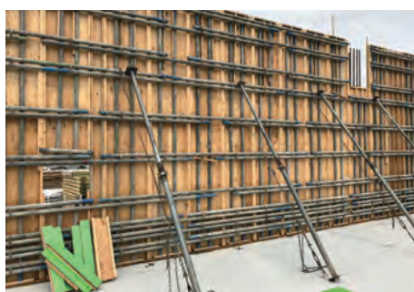
都内学校建設現場②
